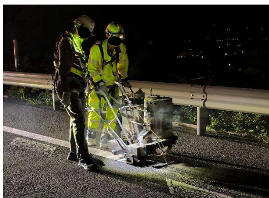
区画線引き直し工事
