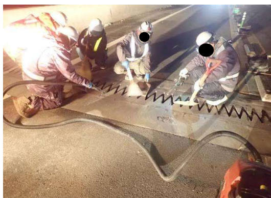
橋梁維持修繕工事
