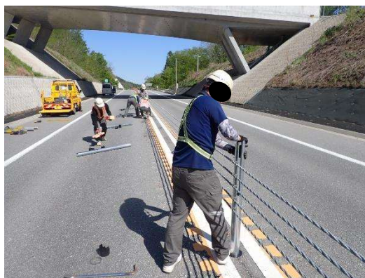
ワイヤーロープ式防護柵補修
