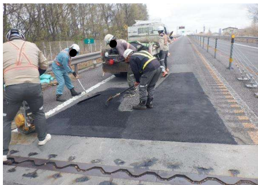
路面補修工事
