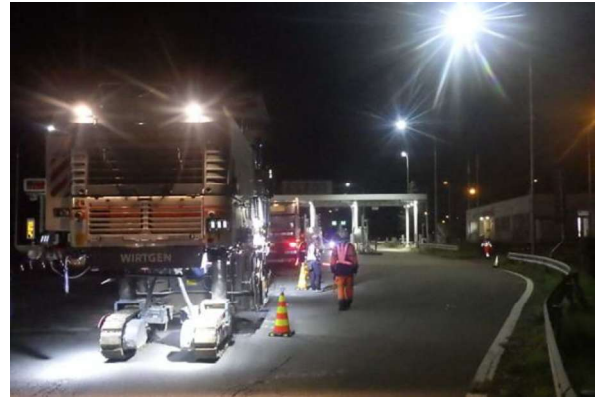
舗装補修工事 作業状況
