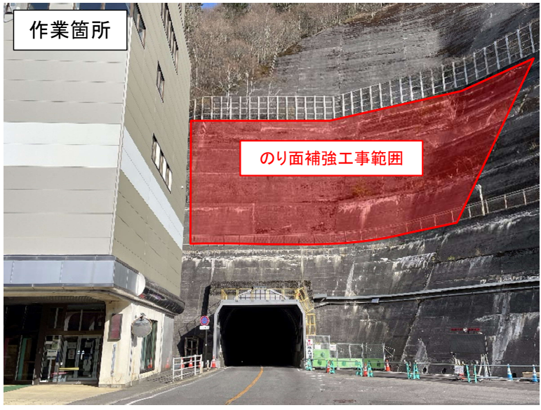
新入山隧道坑口部 法面補強工
