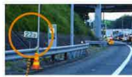
*KP(キロポスト) 道路脇に設置された距離標
