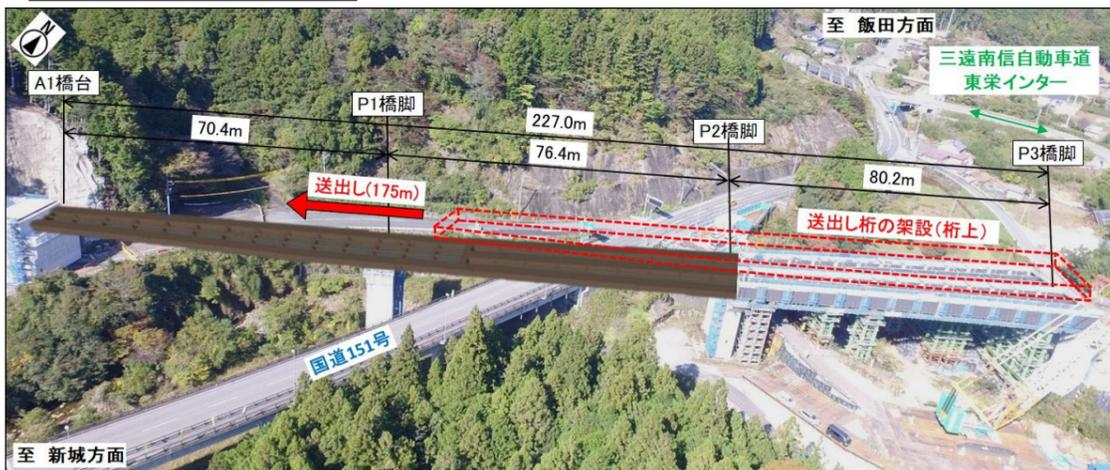
三遠道路1号橋は、全長が227mであり、国道151号と奈根川を横断する3径間の鋼製橋梁です。
