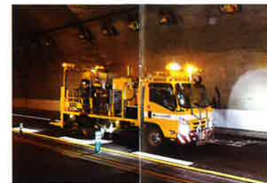
(供用車線の路面標示施工)
