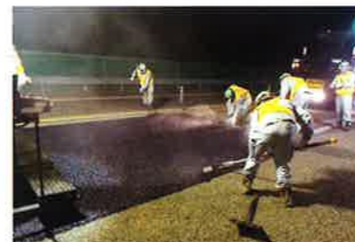
(供用車線の舗装補修)
